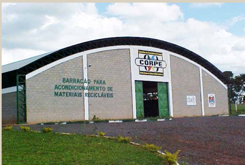
Barracão para acondicionamento de materiais recicláveis
